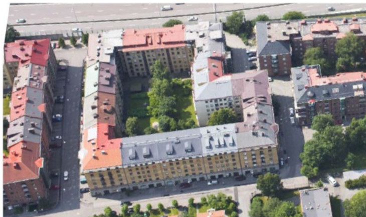
Figur 1. Kvarteret Skålsnäckan. Snedbilder från Stadsbyggnadskontoret. Övre bilden är från väst och nedre från öst.
