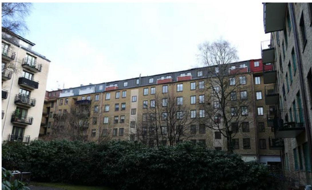
Figur 9. Foto av Antiquum. Taklyft på de östra delarna av kvarteret Skålsnäckan som inte är indraget från takfoten.
